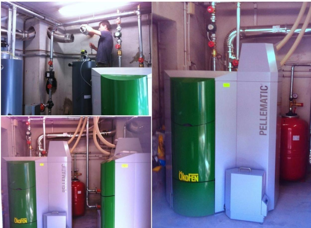
*Chaufferie avec une cascade de deux chaudières OKOFEN avec alimentation par aspiration à partir d'un silo de stockage de 15 Tonnes.*
