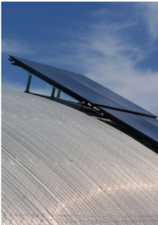
*Chauffage solaire combiné Rotex sur plancher chauffant, avec appoint par chaudière électrique Grétel. 10.40 m<sup>2</sup> de capteurs solaires Solaris posés sur structure métallique et ballon de stockage Sanicube 500L.*
